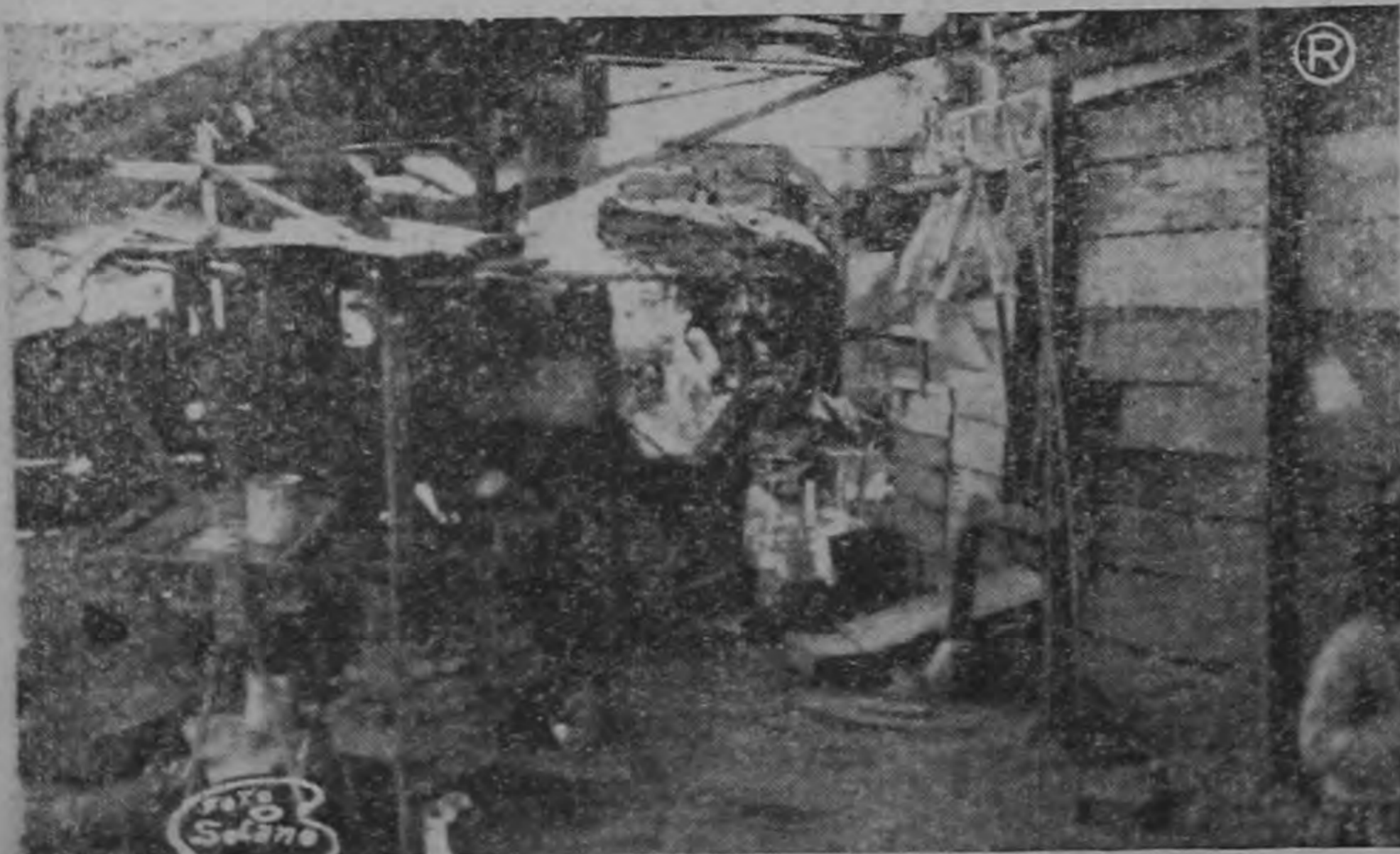
INTERIOR MACILENTO Y LUGUBRE. —Nótese el interior macilento y lúgubre, de una covacha de las que existen en los bajos del Río Torres. Ahí vive hacinada una familia de siete hijos, el padre y la madre. Sin aire, sin luz, la miseria corroe cuerpos y almas. Dura realidad que debía levantar los ánimos de los costarricenses para disponerlos a una acción efectiva e inmediata en contra de tal estado de cosas.
